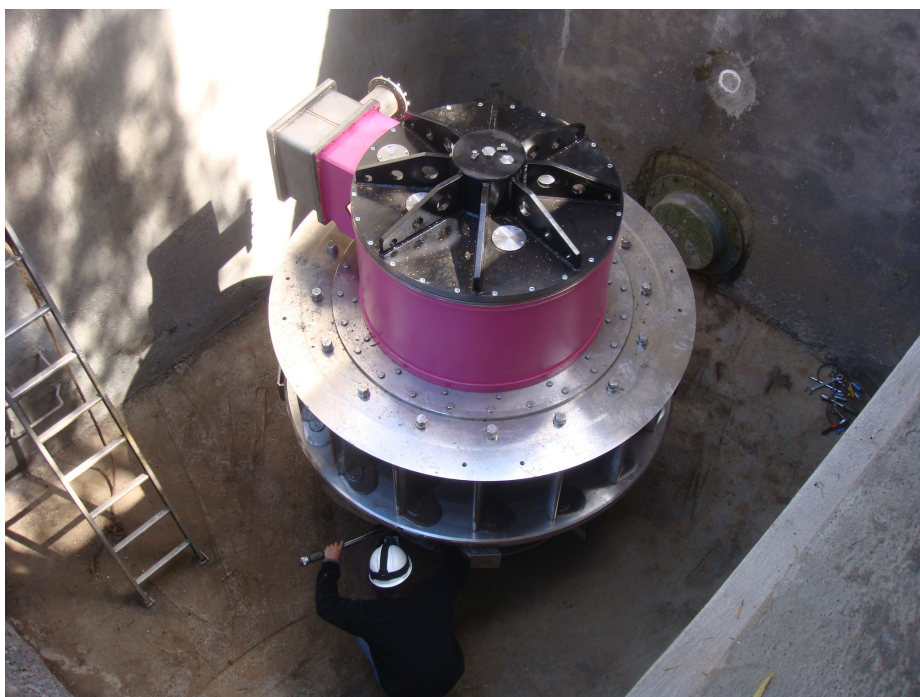
Montaje turbina DIVE. Central Hidroeléctrica Donguil, junio de 2011.
